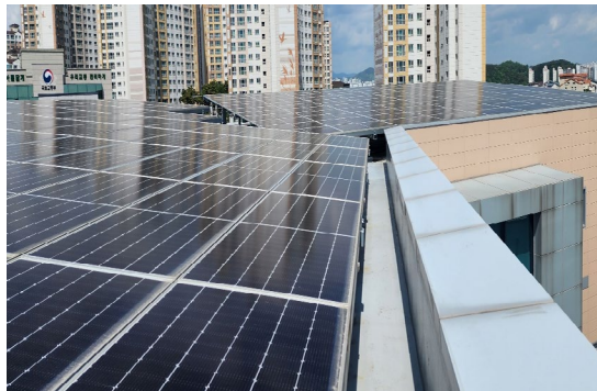
순천 역신농업인센터 건립공사(81kW)
