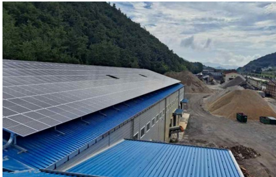
태산태양광 발전소 건립공사 (200kW)
